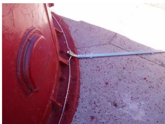
Figure 14 Exemple de mise à la terre d'une murette
