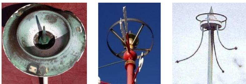
Figure 2 Plusieurs types de paratonnerres radioactifs
