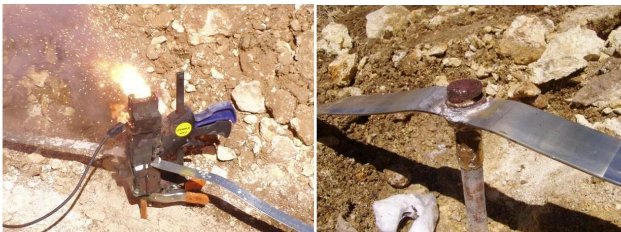
Figure 20 Soudage aluminothermique
