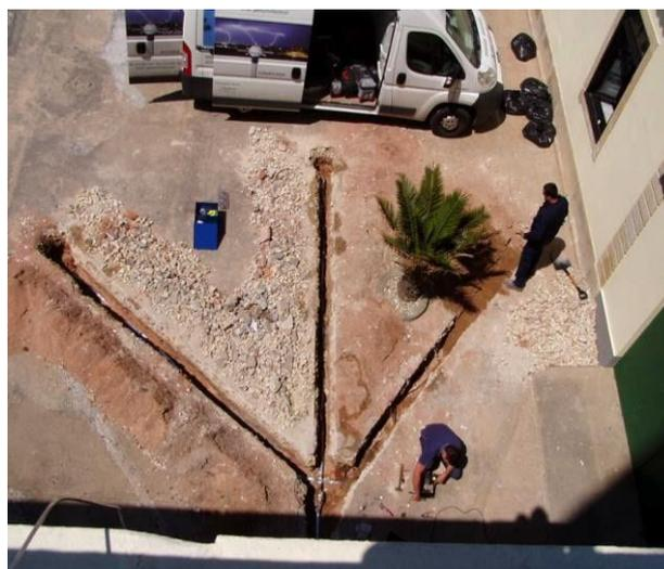
Figure 19 Différents types d'électrodes de terre
