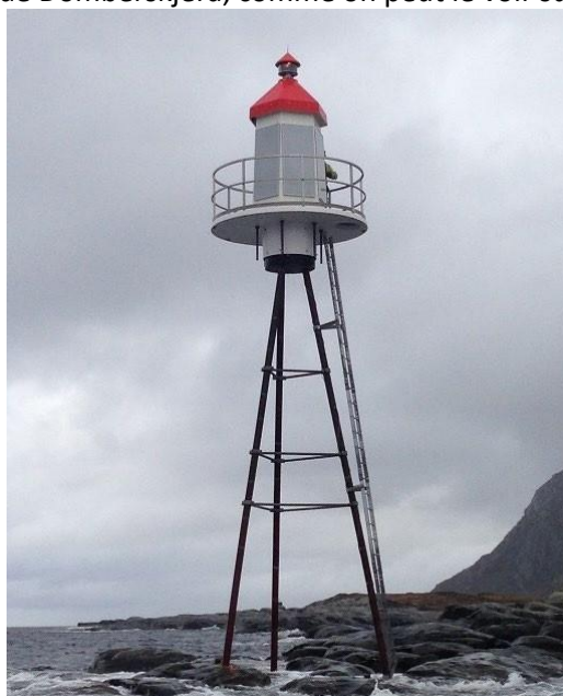
Figure 6 Phare de Domberskjera avec modules solaires blancs
