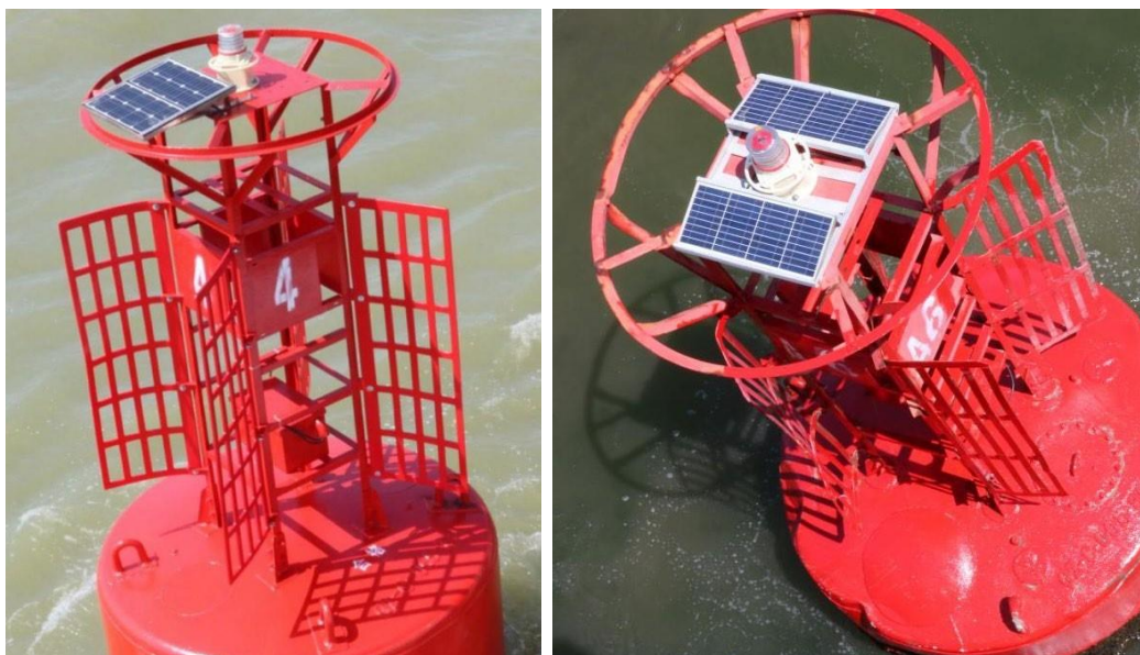
Figure 24 Impact du vent sur les modules solaires installés sur les bouées
