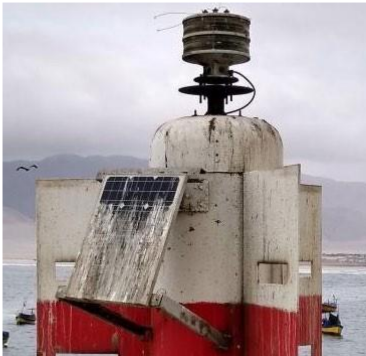
Figure 17 Exemple de module affecté par le guano au Chili
